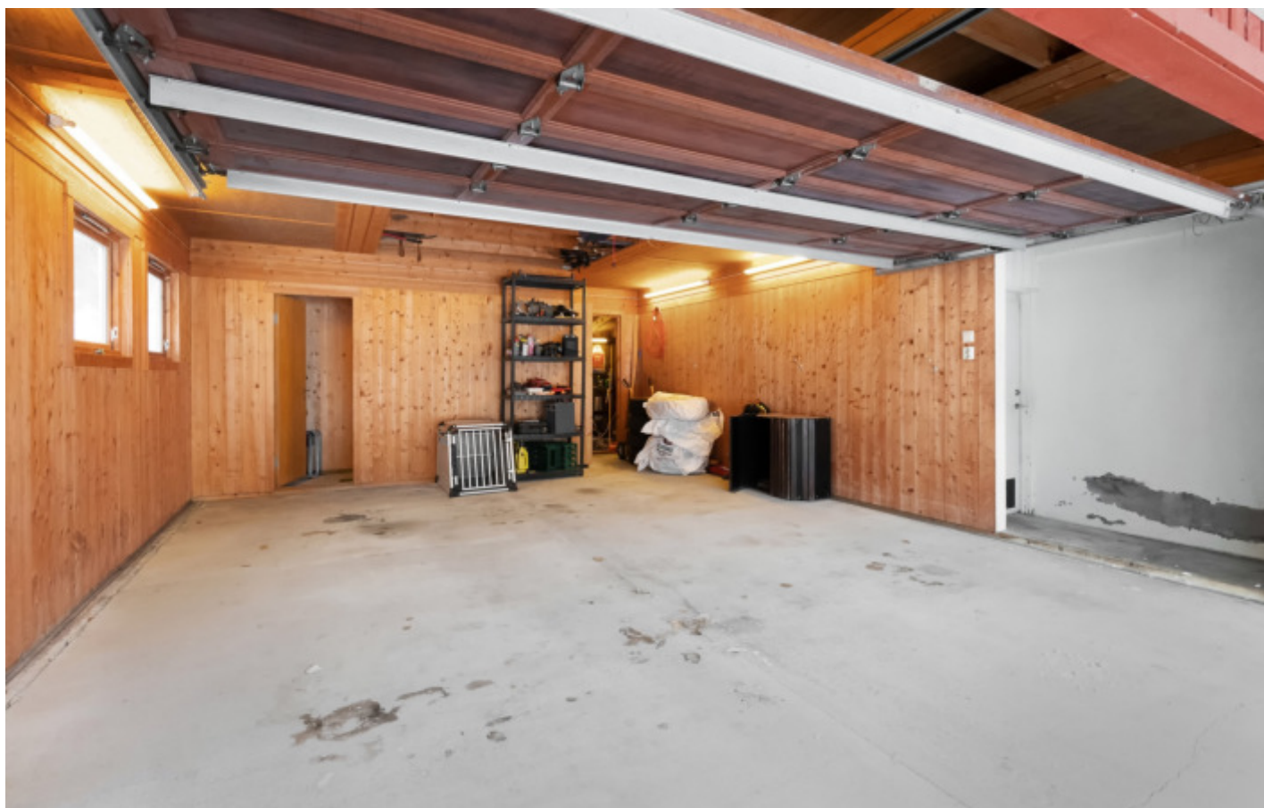
Dobbelt garasje med innredet hems (ikke isolert)
