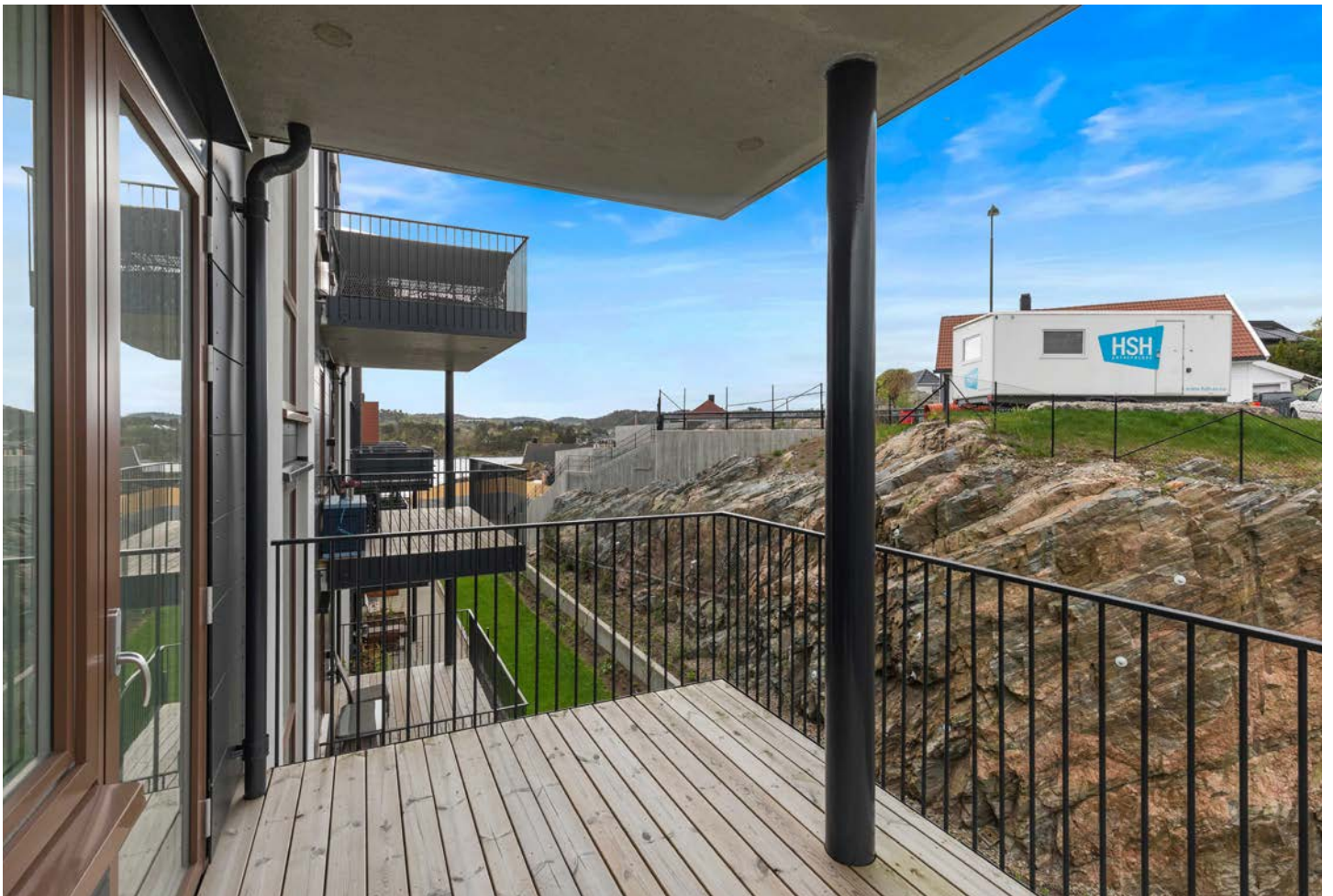
Balkong med morgen og ettermiddagssol.
