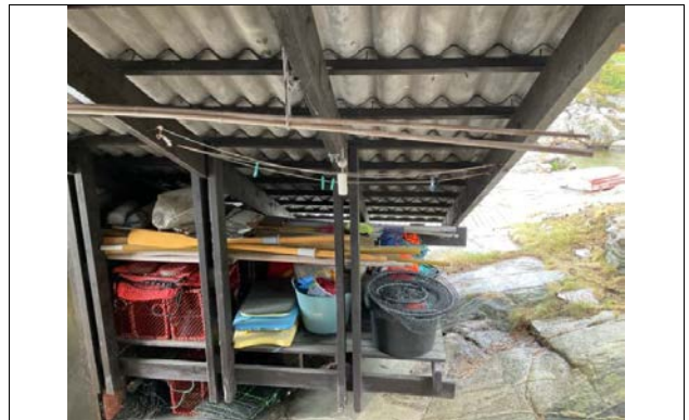
Overbygd lagringsplass utvendig
