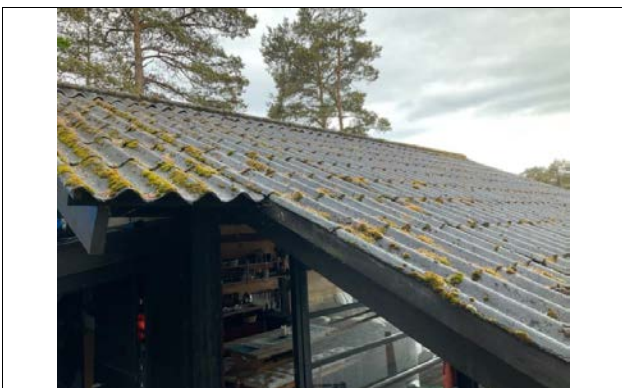
Taket er tekket med eternittplater (inneholder asbest)
