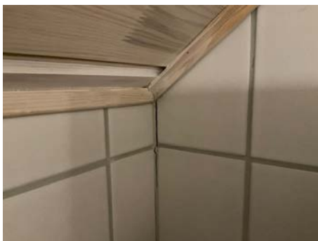
LOFTSETASJE > BAD (LOFTSETASJE)
