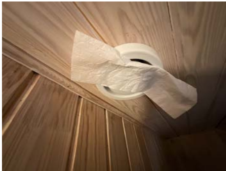
LOFTSETASJE > BAD (LOFTSETASJE)
