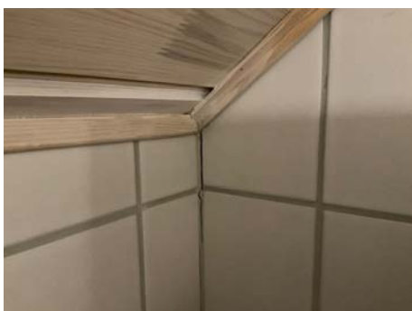
LOFTSETASJE > BAD (LOFTSETASJE)
