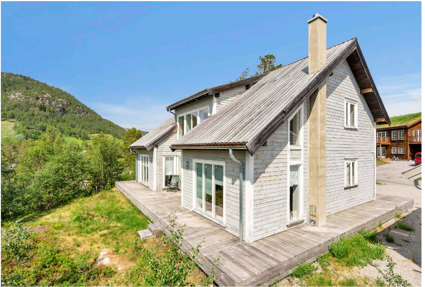
Terrasse rundt flere sider av boligen
