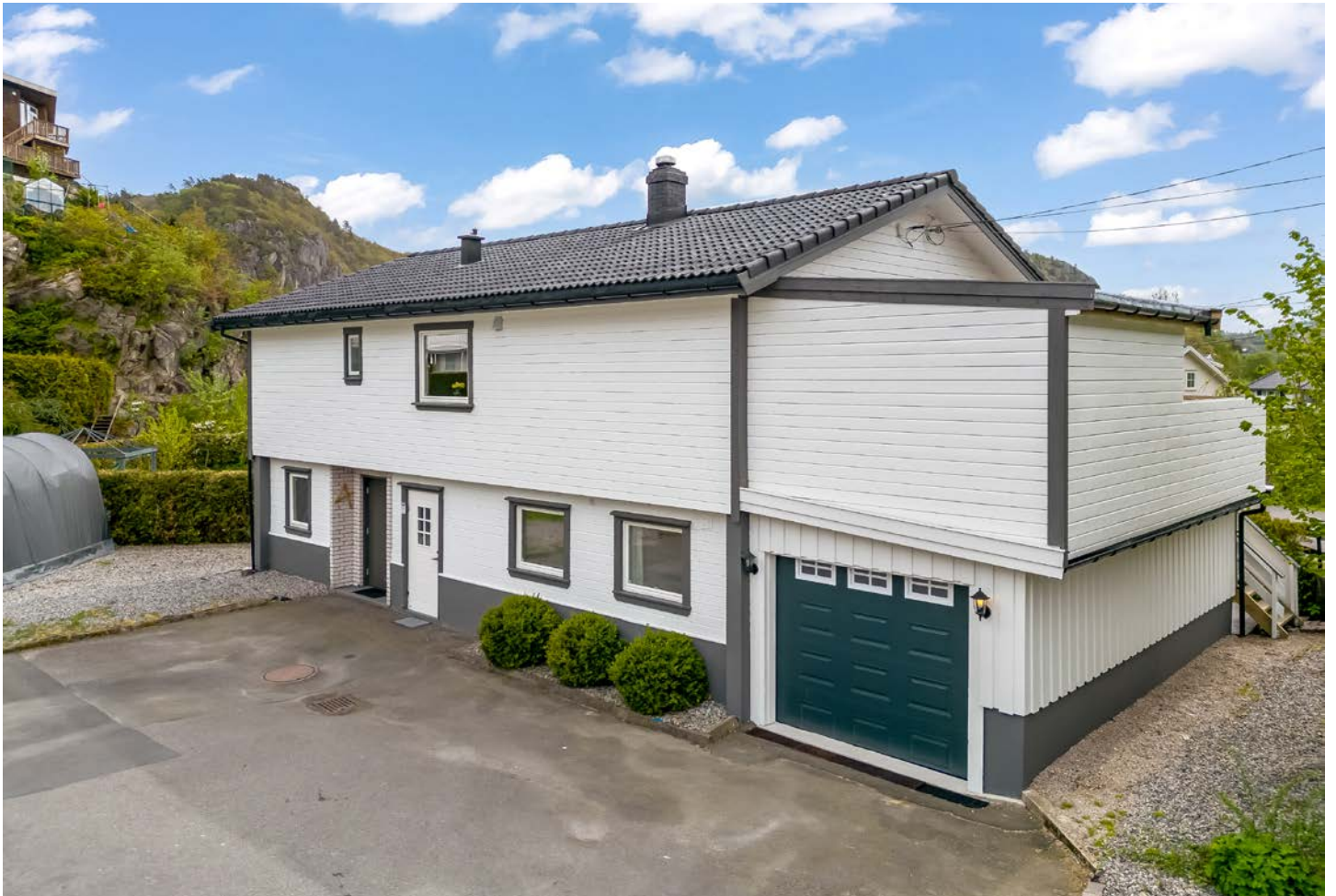
Bakside med garasje og inngang bolig.
