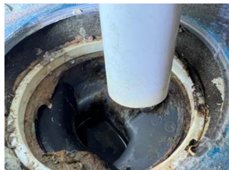
ETASJE > BAD I 1. ETASJE
