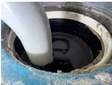
LOFT > BAD I LOFTSETASJE
