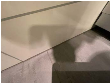
ETASJE > BAD I 1. ETASJE
