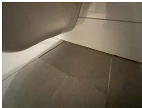
LOFT > BAD I LOFTSETASJE
