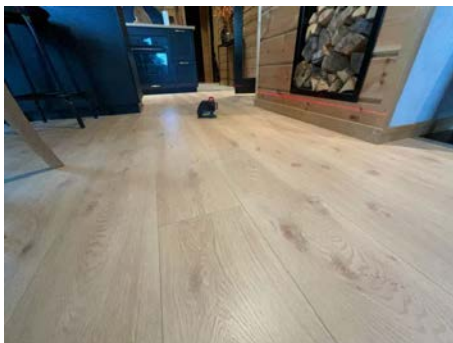
Høydeforskjeller kontrollert.
