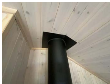
Pipegjennomføring.
