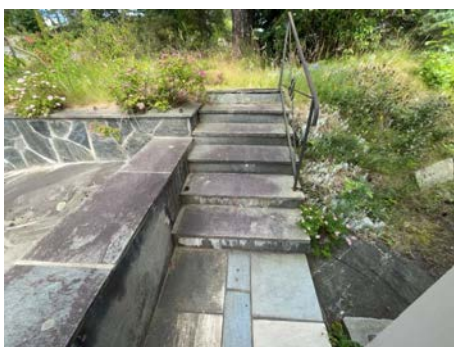
Utvendig trapp i tre med skiferheller i trinn.
