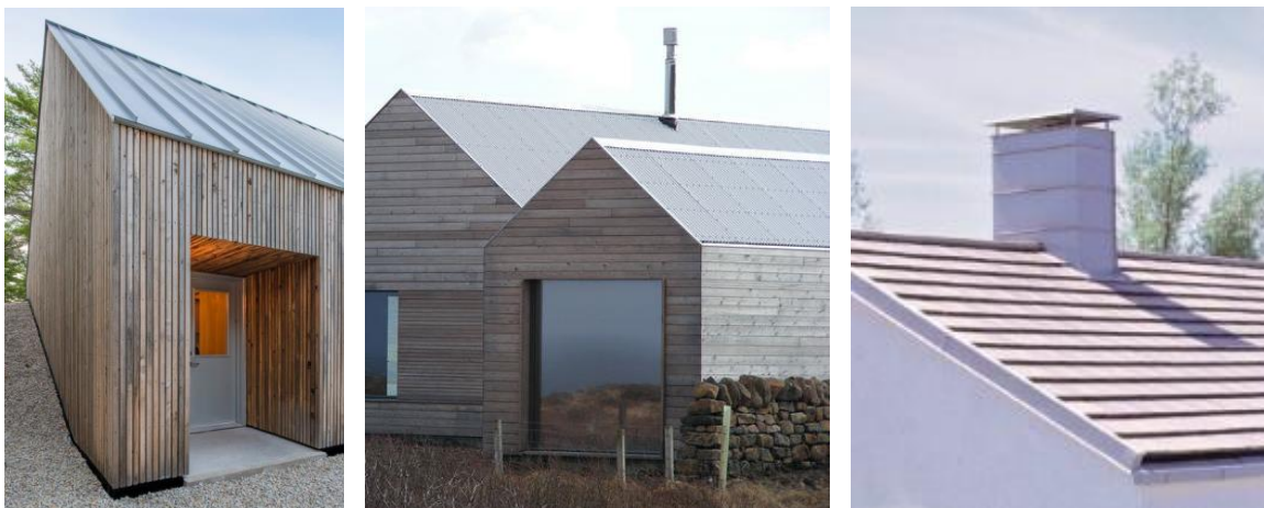
Eksempel på enkelt og presist utført sinktak tv. Eksempel på aluminiums tak midt. Th. Minster betong stein
