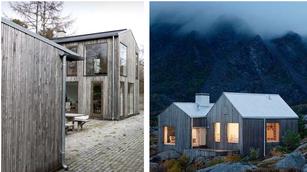
Tv. eksempel på presis og enkel detaljering av nedløpsrør og overgang tak-fasade. Th eksempel på bra integrert pipe og oppstikk i aluminium.
