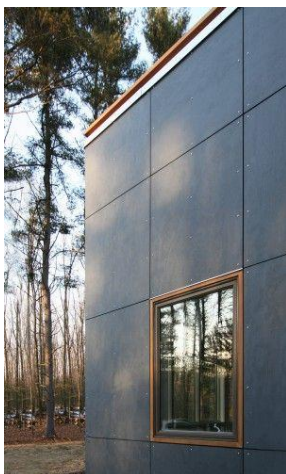
Eksempel tv. på plassering av fibersementplater hvor vindu og plater passer sammen. Utdrag th. fra Cembrit katalog på de farger og typer som kan benyttes.
