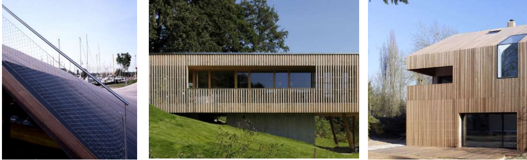
Eksempel på veldig diskret rekkverk utført i metal nett tv. Eksempel på tre spiler rekkverk midt. Eksempel integrerte rekkverk i tett fasade th.
