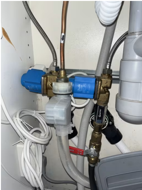
Waterguard montert i kjøkkenbenken som stenger vannet ved en eventuelt lekkasje.
