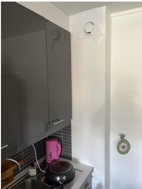
Avtrekk i fra rommet inn i felles luft sjalt.
