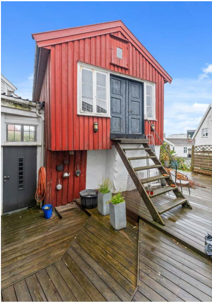
Eldre uthus av god størrelse, men oppgradering er nødvendig.
