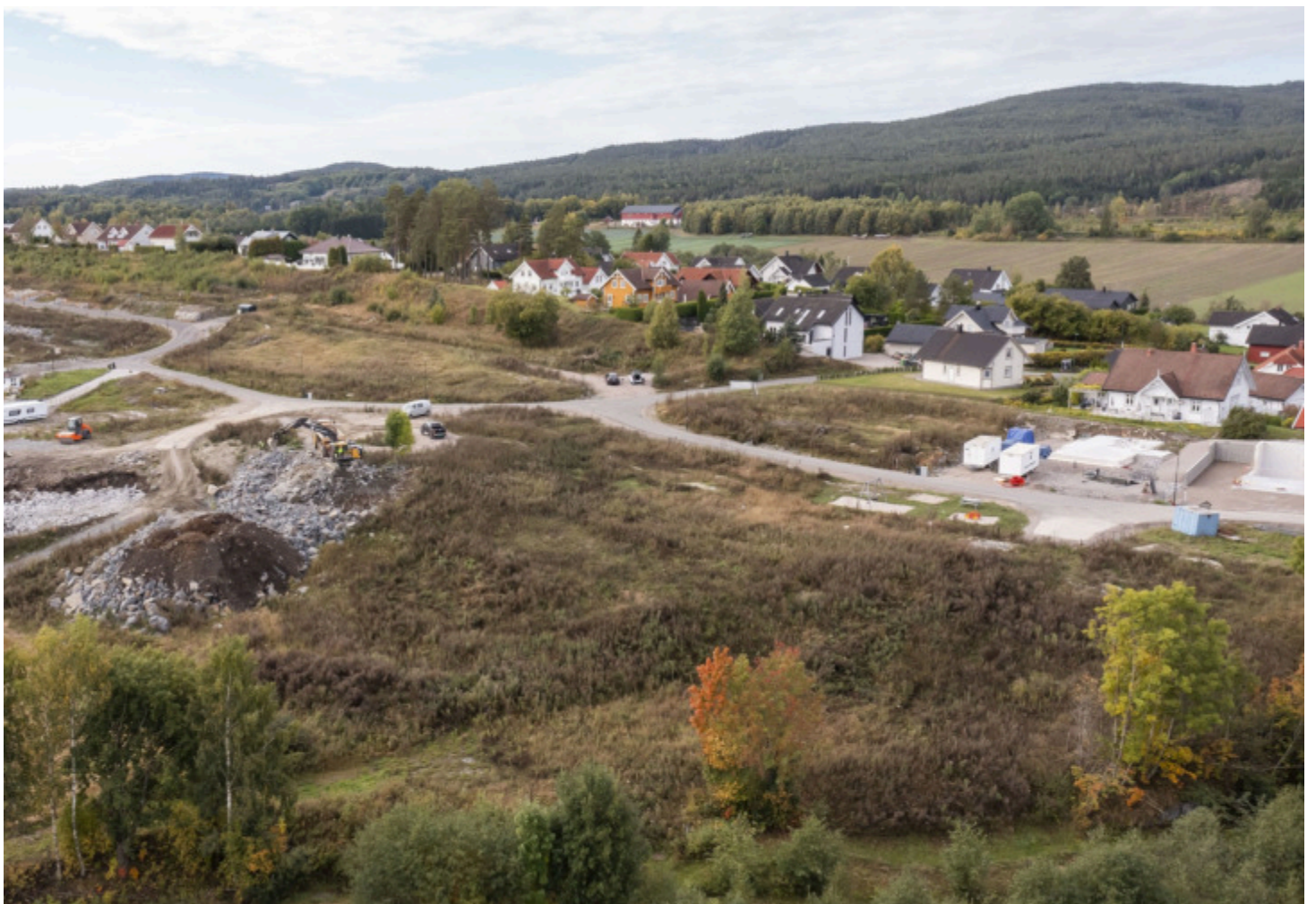
Tomtene er byggeklare med vei, vann og kloakk til tomtegrense
