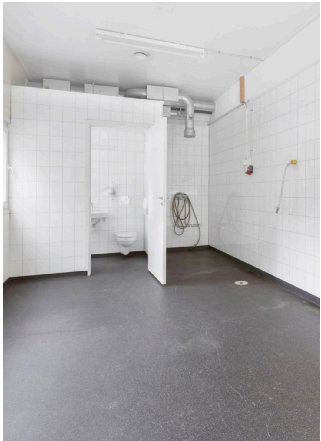
Verksted/våtrom 1.etg. med wc.
