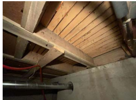
Delvis åpen konstruksjon mellom krepkjeller og matbod.
