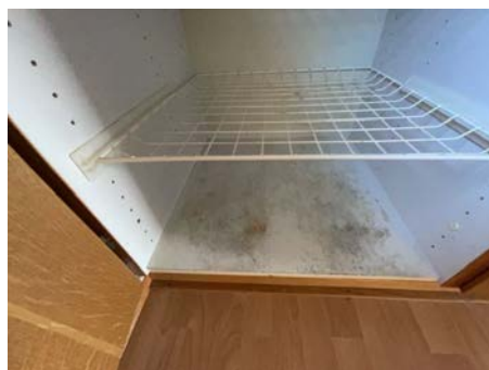
Svelling/bruksmerker på innredning.
