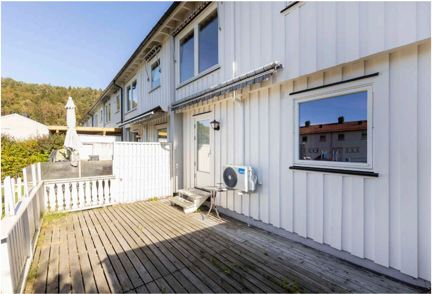
Vestvendt markterrasse med gode solforhold
