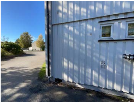
Utvendig oversikt av bod dør.
