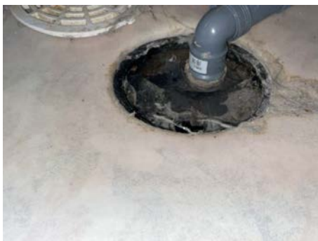
Belegg er klemt i PVC sluk
