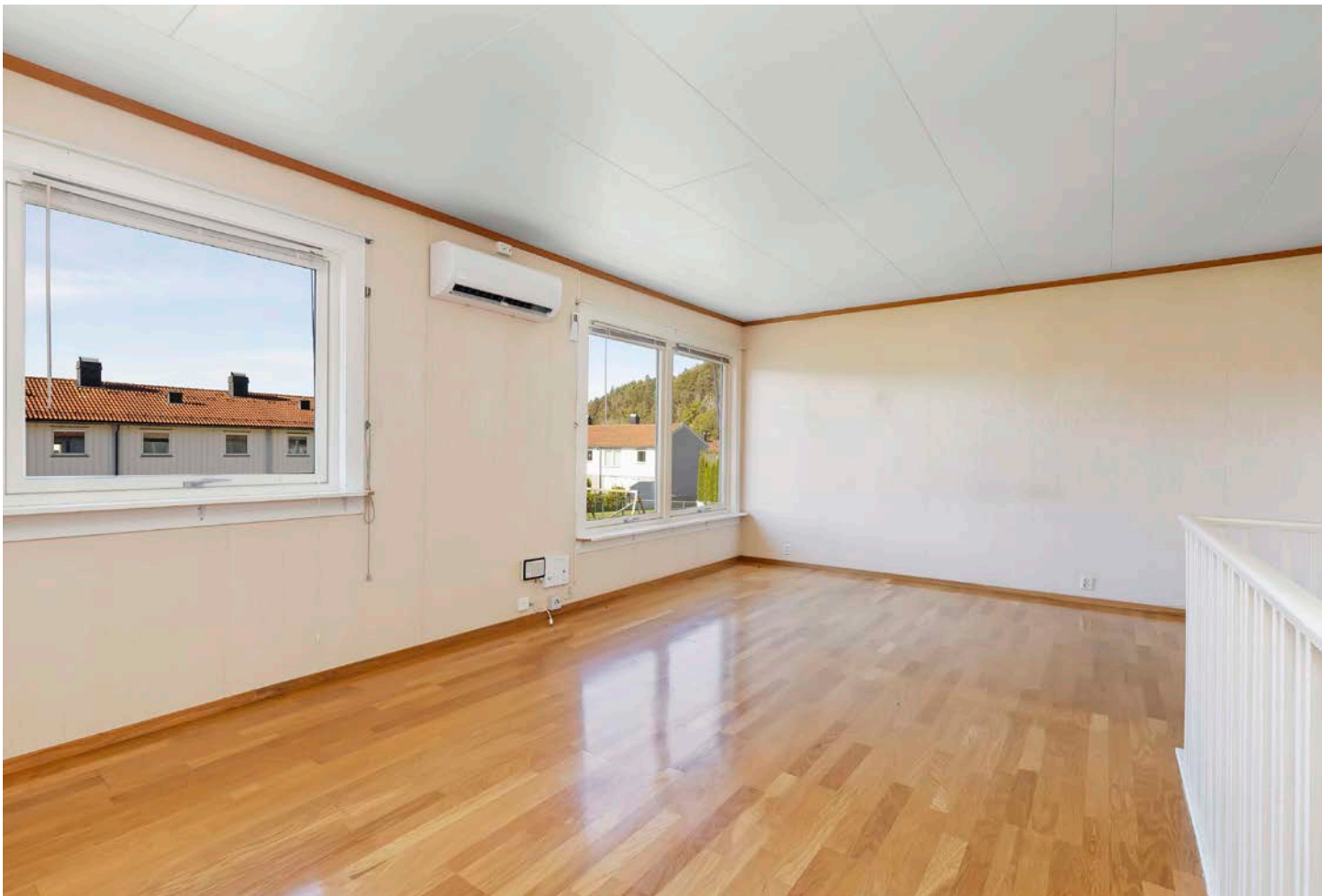
I stuen er det montert varmepumpe - i gang i 1. etasje er det vedovn
