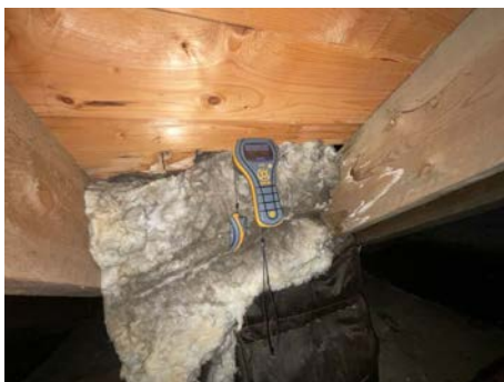
Ingen fuktavvik i undertak rundt lufting.
