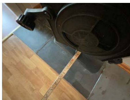
Avstand fra front ovn og ildfast plate er for liten. Denne er målt til 20 cm mot krav på 30. TG utløses på dette punktet.
