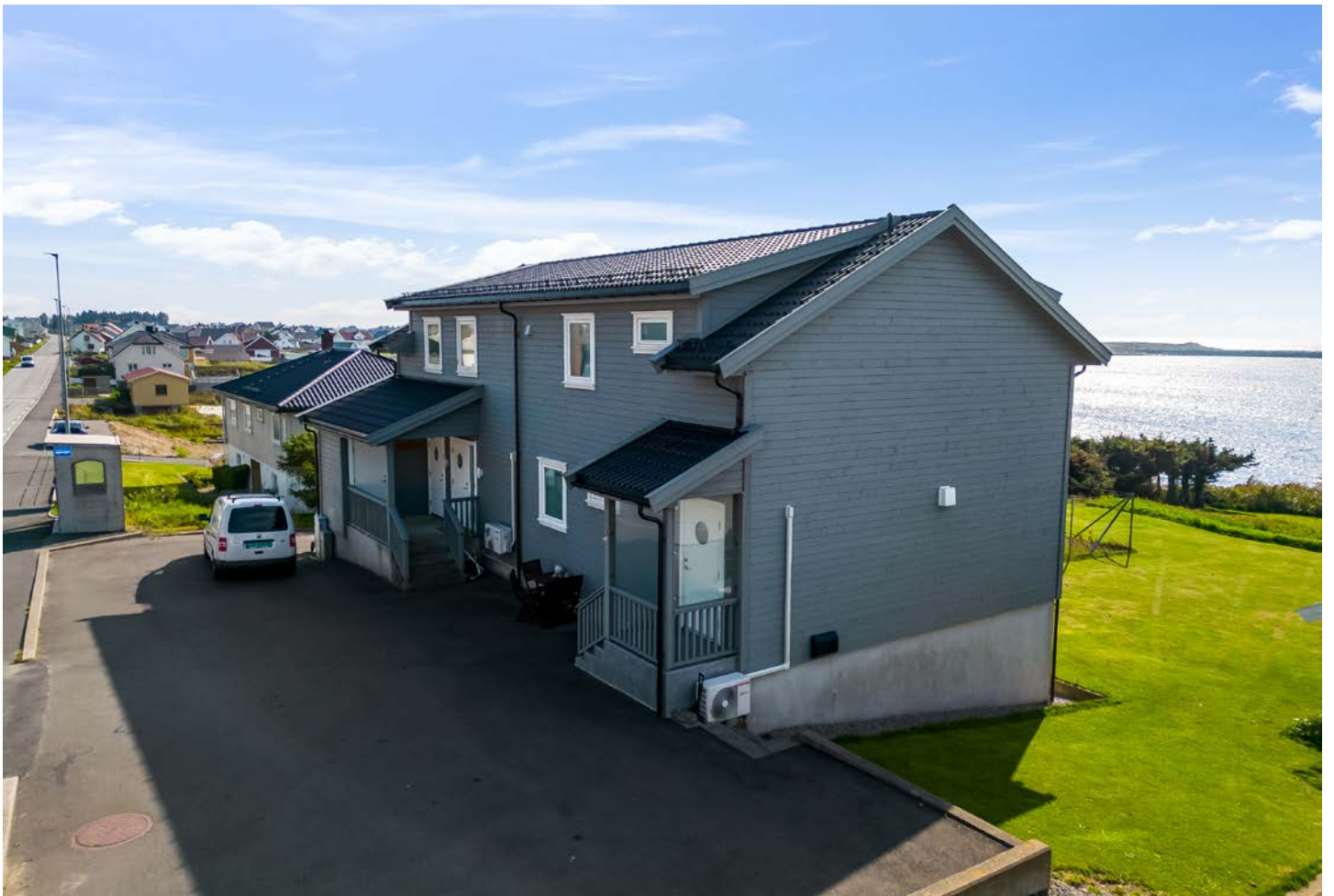
Parkering på asfaltert uteområde.
