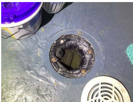
Eldre sluk uten membran
