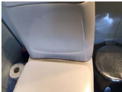
Kondensering på sisterna
