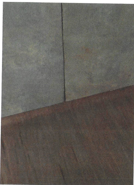
Eksempel på merker etter fukt i panel. Eksempel på fuktskade i baderomsplate i dusjen.
