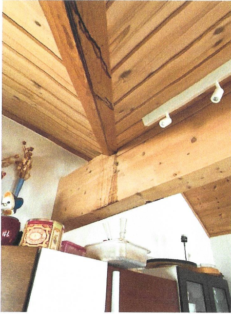
Begge bilder viser lekkasje av kondens i takkonstruksjonen. Henholdsvis på kjøkken, bilde til venstre, og på bad.
