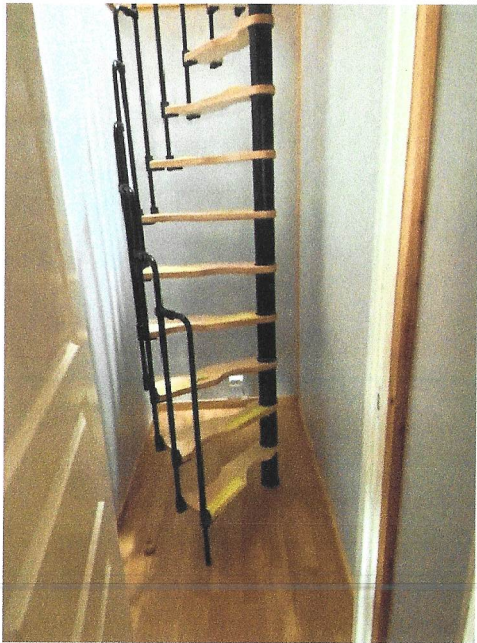
Bratt vindeltrapp med ikke godkjent rekkverk i trapp eller på toppen av trappen.
