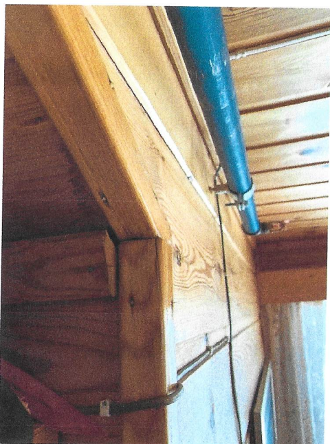
Eksempel på merker etter fukt i panel. Eksempel på fuktskade i baderomsplate i dusjen.
