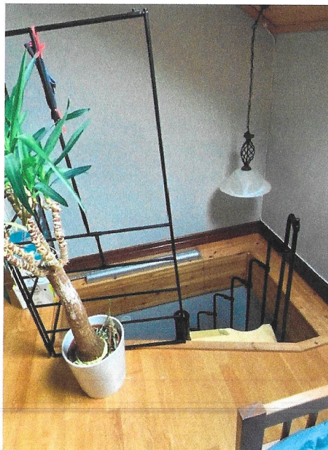
Bratt vindeltrapp med ikke godkjent rekkverk i trapp eller på toppen av trappen.
