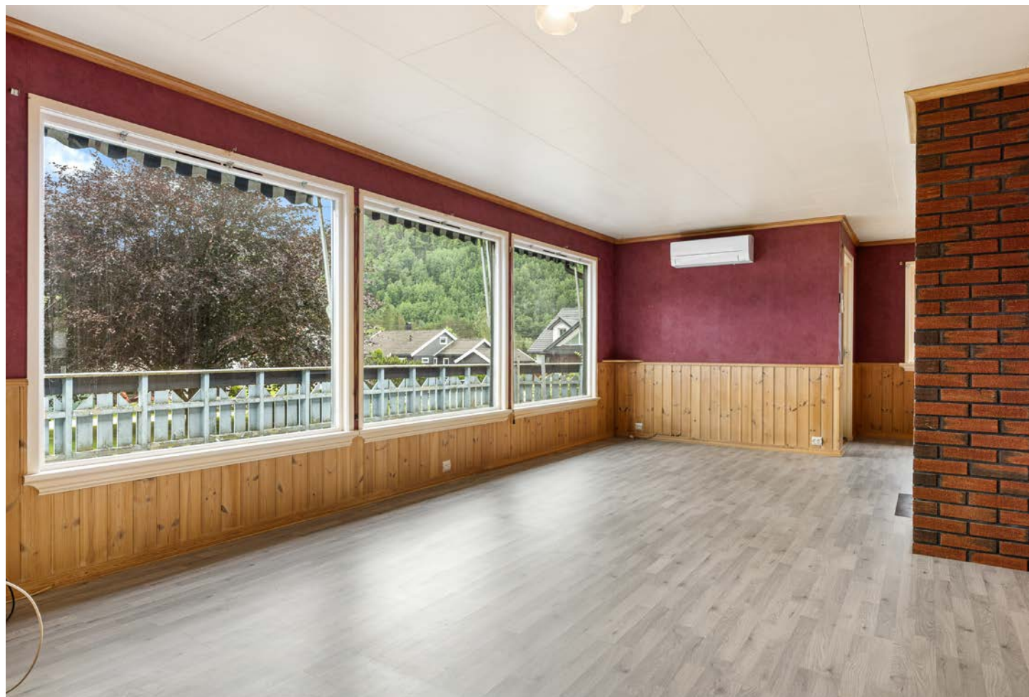
Hovedstue med varmepumpe montert
