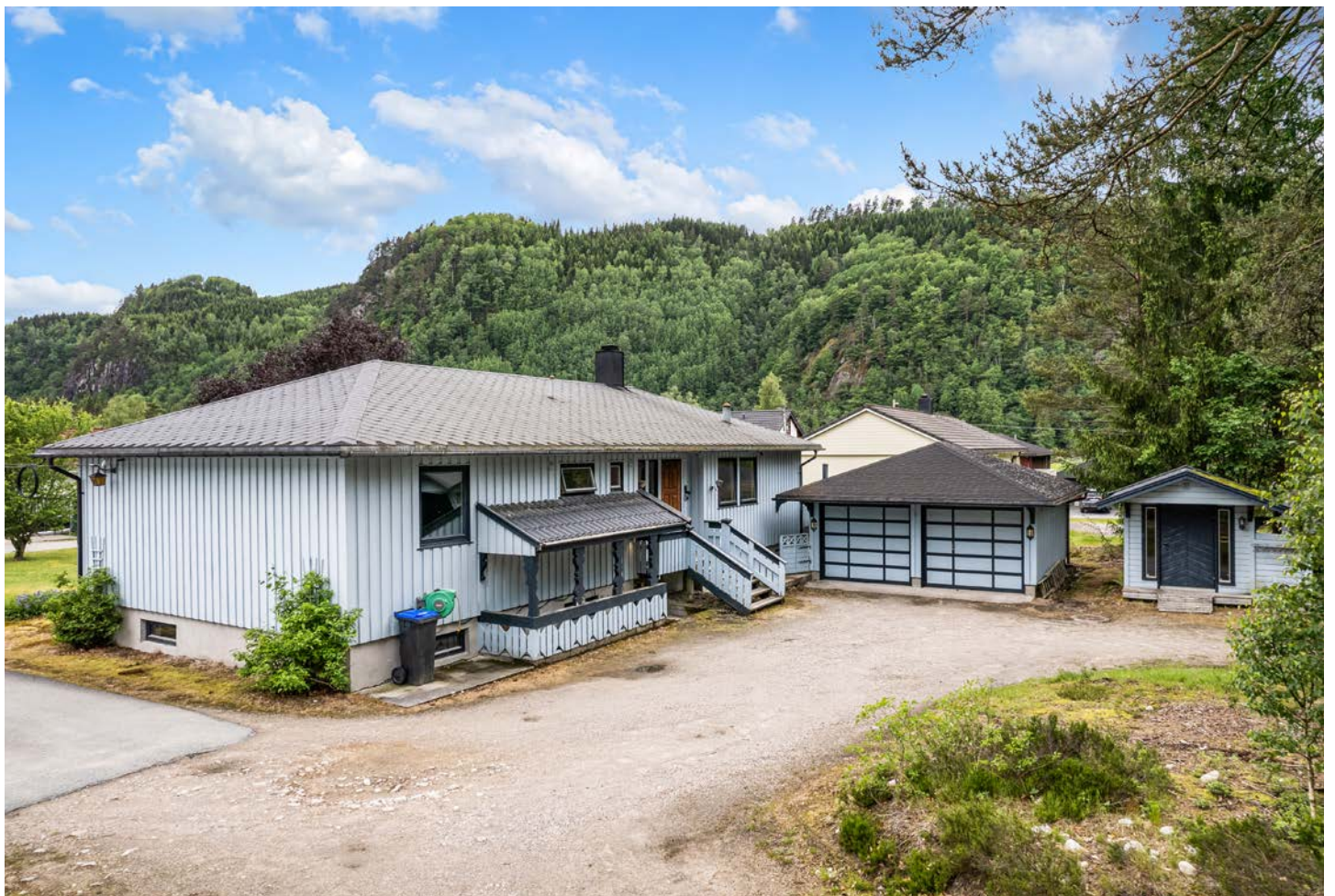
Bakside med garasje og bod.
