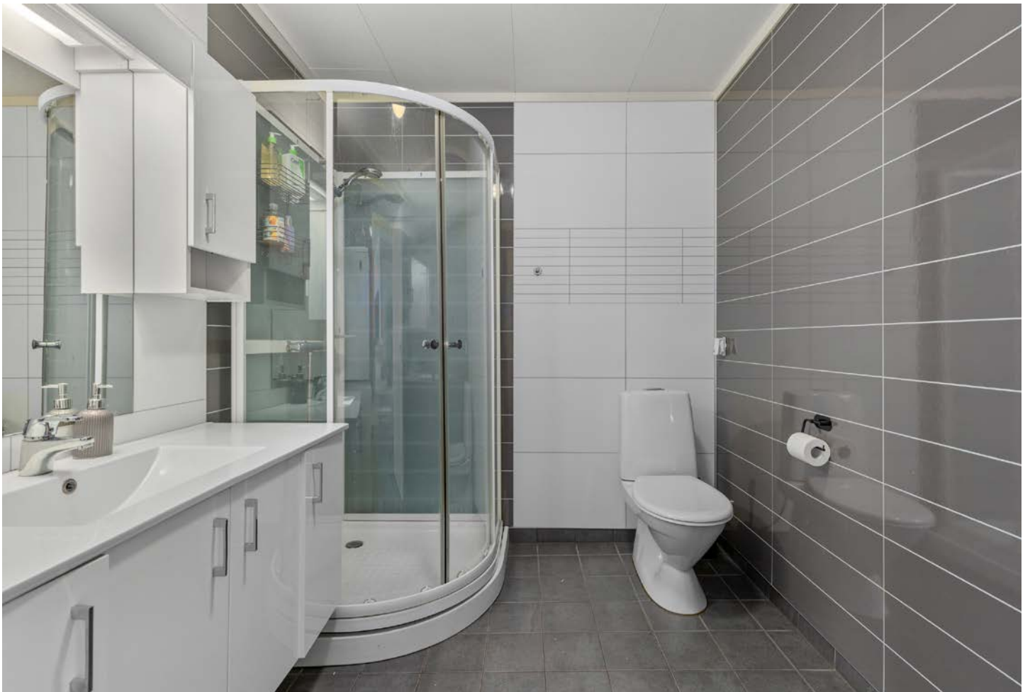
Bad med fliser på gulv og varmekabler
