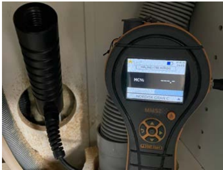
Hulltaking - Fuktmåling - Tørr konstruksjon i hulltakingsområdet.
