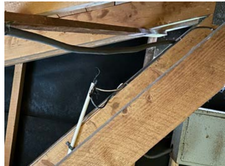
Manglende klamring av strøminntak
