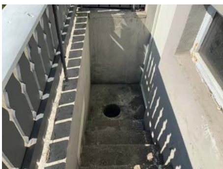
Trapp til kjellerinngang
