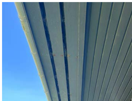
Luftspalter i gesims.
