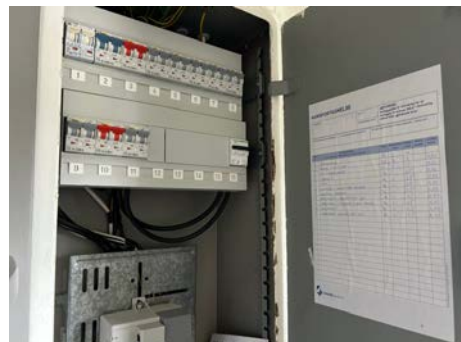
Manglende klamring av strøminntak
