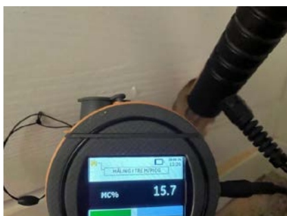
Hulltaking - Fuktmåling - Tørr konstruksjon i hulltakingsområdet.
