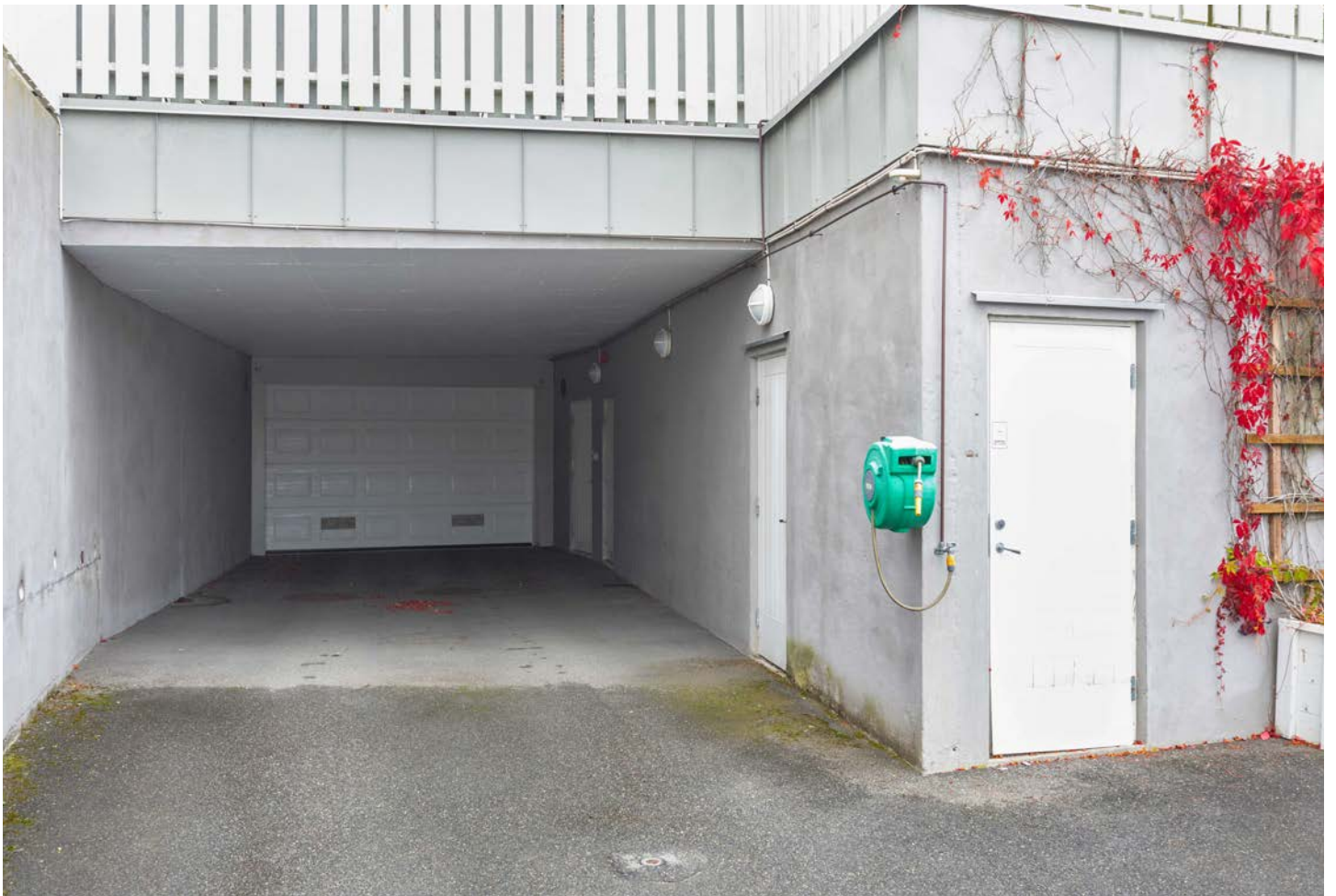
Innkjørsel til garasjeanlegget
