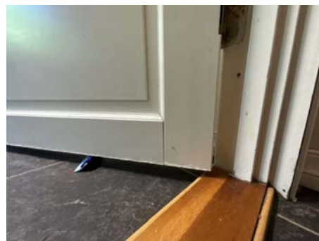
Dør til vaskerom
