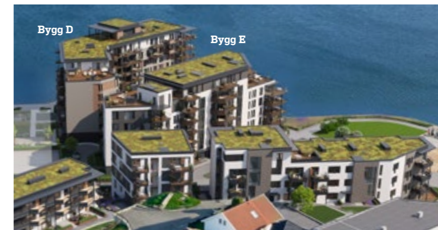
Et Sedumtak reduserer vannavrenningen med 50 %. Det renser også luften, fjerner svevestøv, CO 2 NO x og aerosoler.
