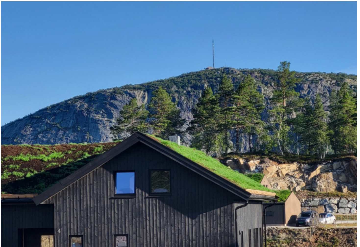
Det gror på taket! Selgers bilde tatt i slutten av juli-23
