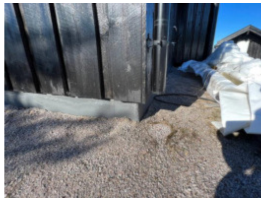
Del av støpt plate.
