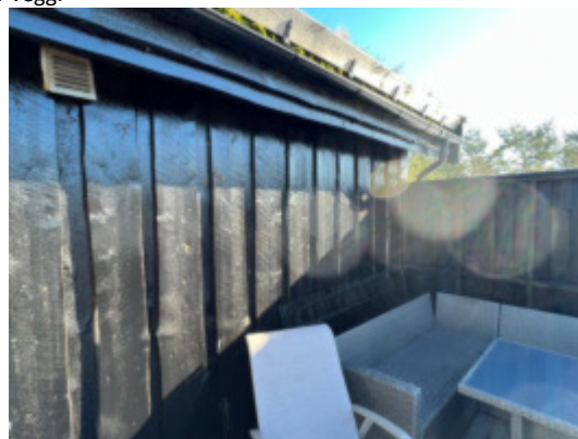
Del av vegg.
