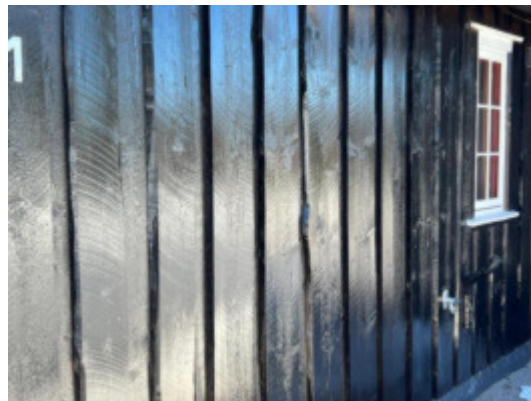
Del av vegg.
