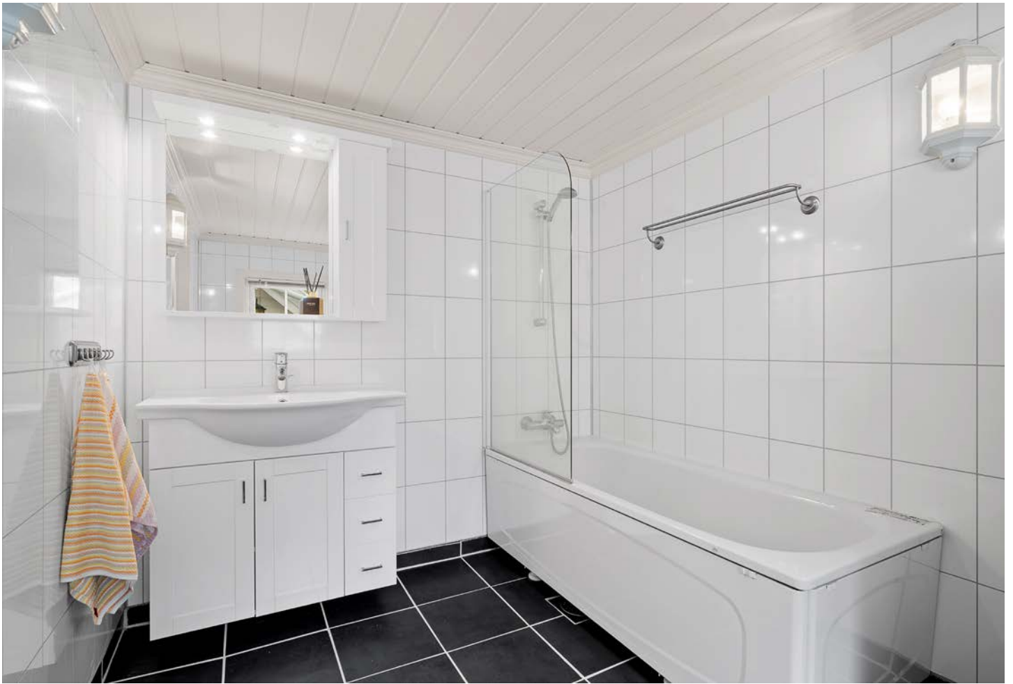
Pent flislagt bad (del av tilbygget) med varmekabler i gulv. På vegg er det våtromspanel (Fibotrespo el. tilsvarende.)
