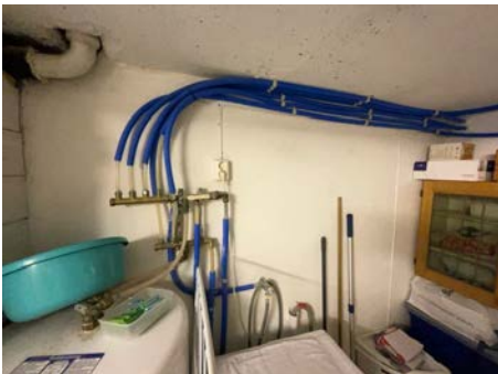
Utsnitt rør-i-rør.
