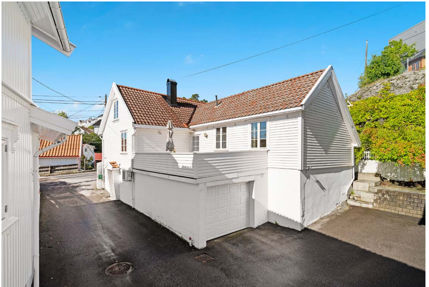
Fasade med parkeringsareal og garasje
