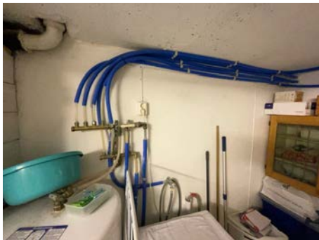
Utsnitt rør-i-rør.
