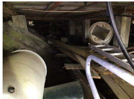
Under hytten. Her ser man også deler av etasjeskille fra undersiden,
