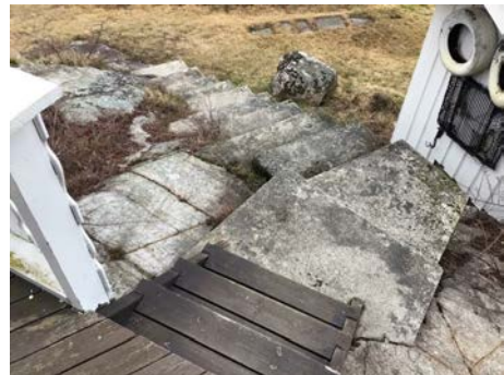
Trapp ned fra terrasse.
