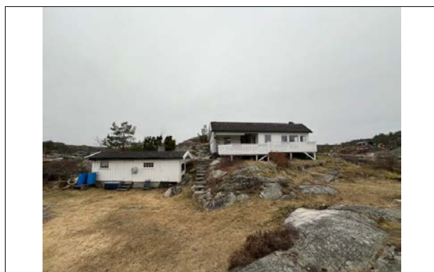
Bilde tatt på befaringsdagen 13-3-2024.
