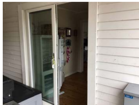
Dør inn til kjøkken, denne dør fungerer som hovedingangsdør.
