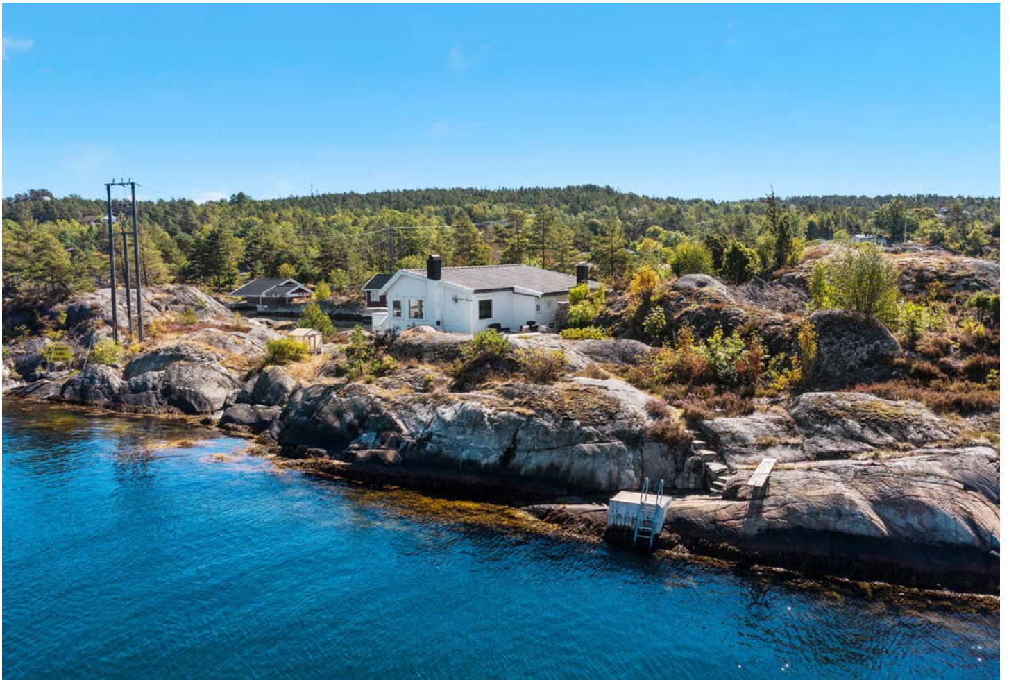
Hytta har alt på ett plan og holder eldre standard. Det er innlagt strøm, men ikke innlagt vann.
