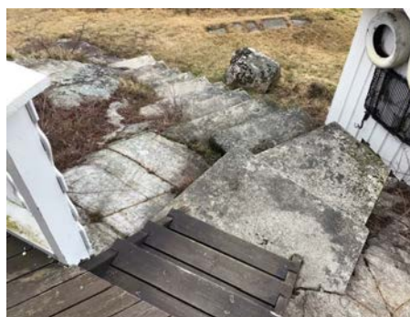
Trapp ned fra terrasse.
