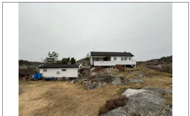
Bilde tatt på befaringsdagen 13-3-2024.
