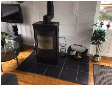
Montert ovn i stue.
