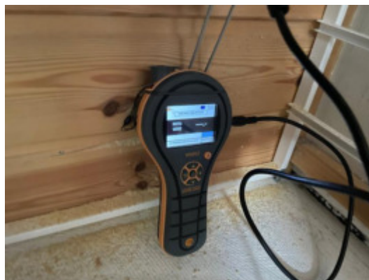
Hulltaking - Fuktmåling - Tørr konstruksjon.
