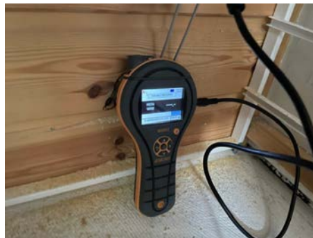
Hulltaking - Fuktmåling - Tørr konstruksjon i hulltakingsområdet.
