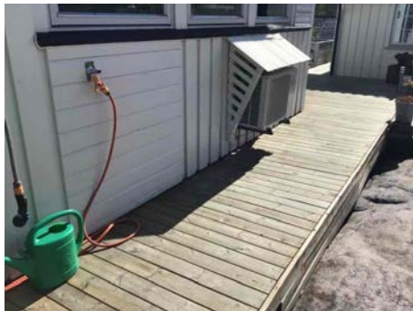
Kledning nær terrasse.
