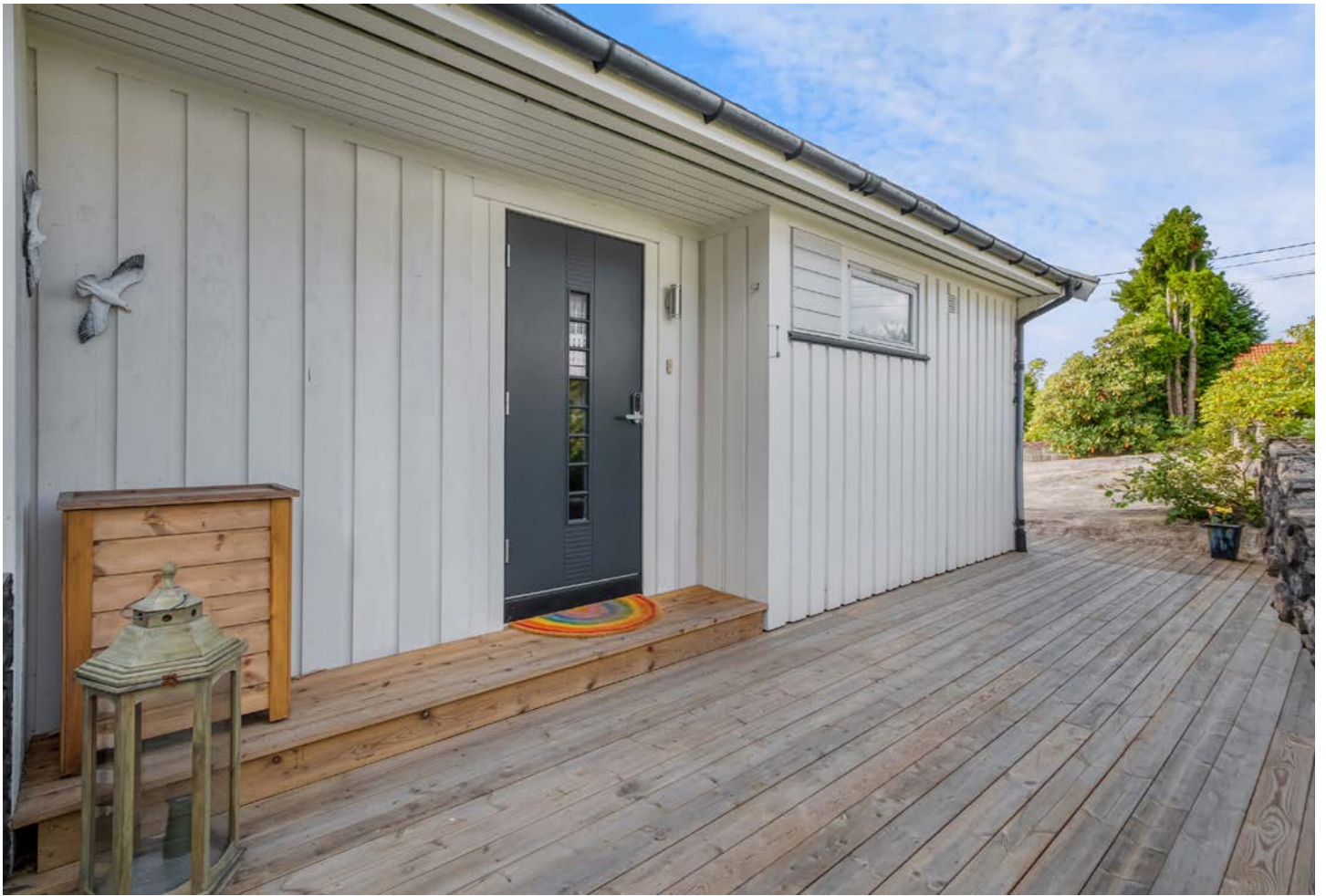
Boligens hovedinngang, med nyere ytterdør.
