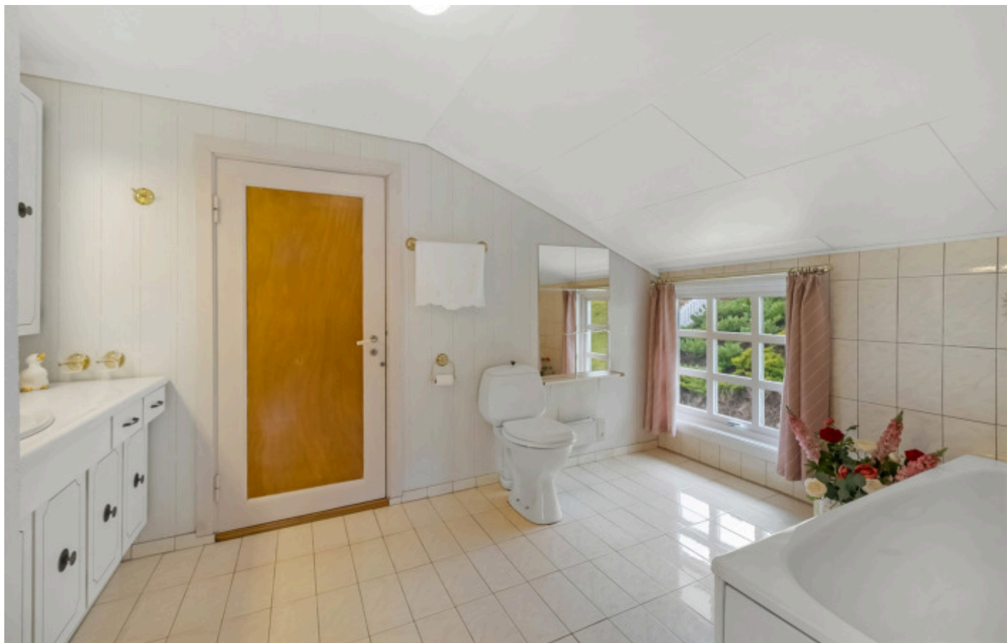
Bad på loftet. Her det fliser på gulv med varmekabler og på vegg. Innredet med baderomsinnredning, toalett og badekar.
