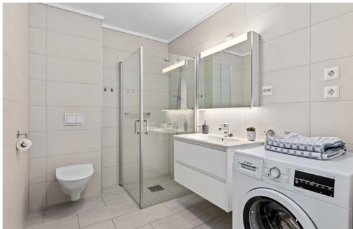
Lyst og fint baderom. Veggflatene er utført med fliser og det er benyttet slette malte plater i tak / himling. Flislagt gulv
