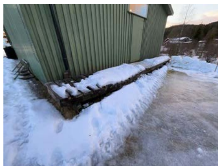
Rampe i tre mot nord.
