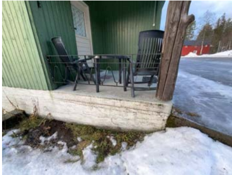
Platting ved inngangsparti.
