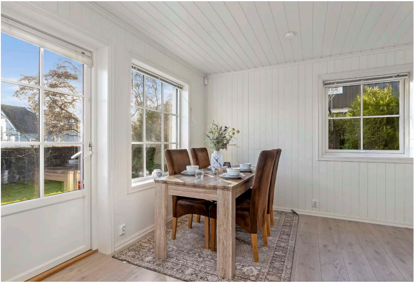
Det er installert varmepumpe i stue i 2024.
