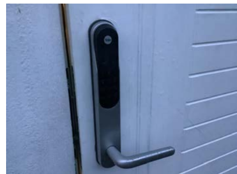
Kodelås er montert ved inngangsdør.
