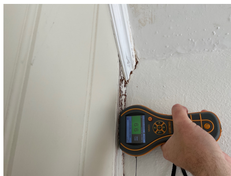
Tørt ved fuktmåling.
