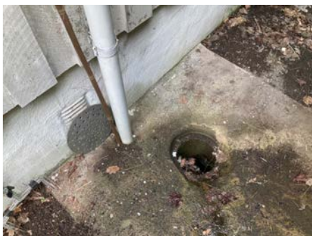
Taknedløp på bakside som ledes til kum/avløp
