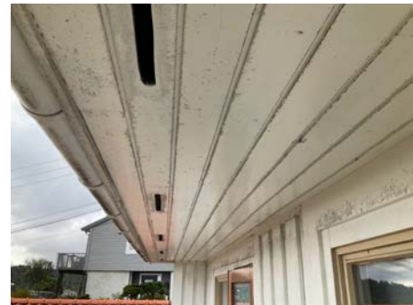
Luftespalter i gesimser
