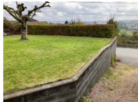
Forstøtningsmur langs gårdsplass fra ca 2010
