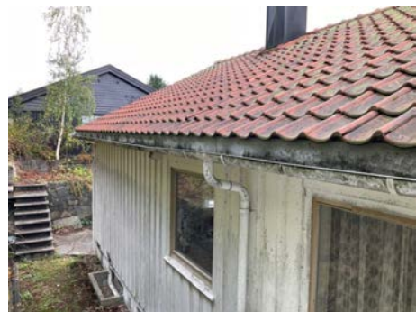
Slitasje og ujevnt oppheng/fall på takrenner
