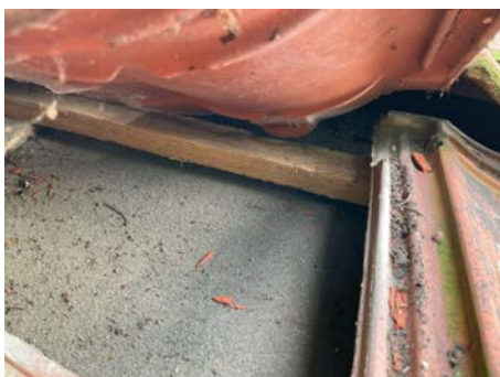
Stikk kontroll undertak. Normal slitasje registrert.
