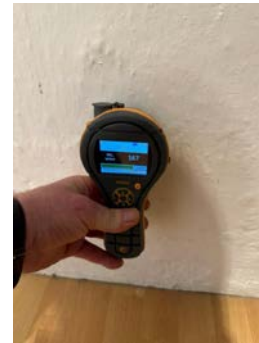
Normale fuktverdier i kjellervegg mot øst(ny drenering)
