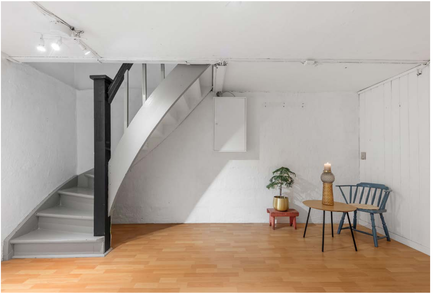
Kjellerrom - her finner du det elektriske anlegget.
