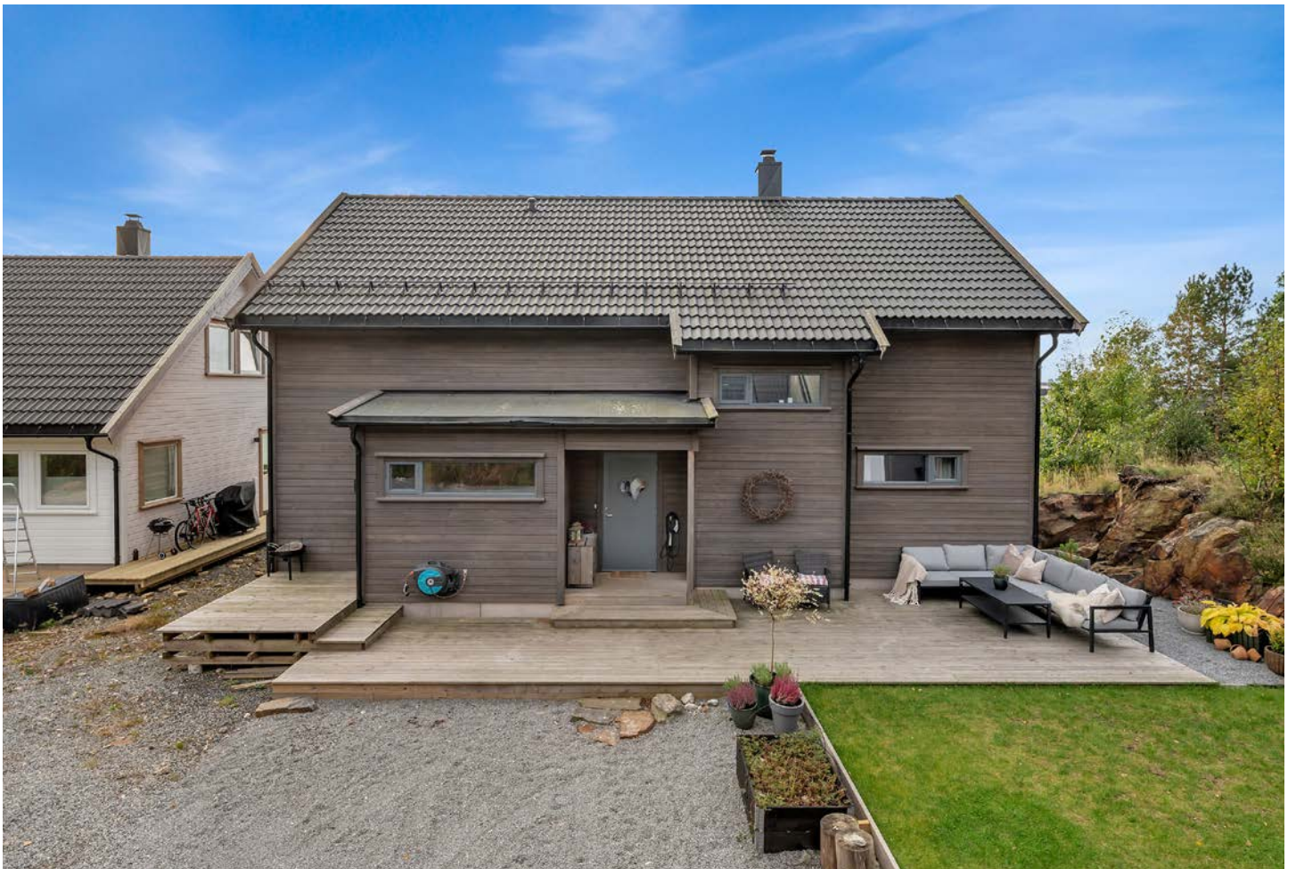
Inngangspartiet er flott opparbeidet med romslig platting
