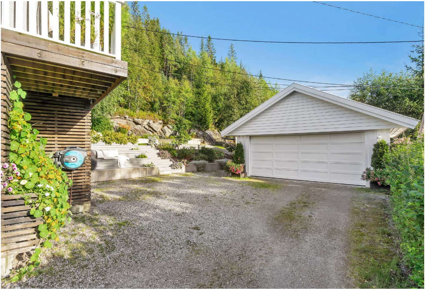
Bod under terrasse og dobbel garasje på 41m 2 .
