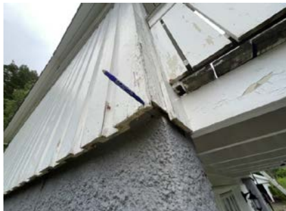
Mykt treverk i bunnen av hjørnebord.
