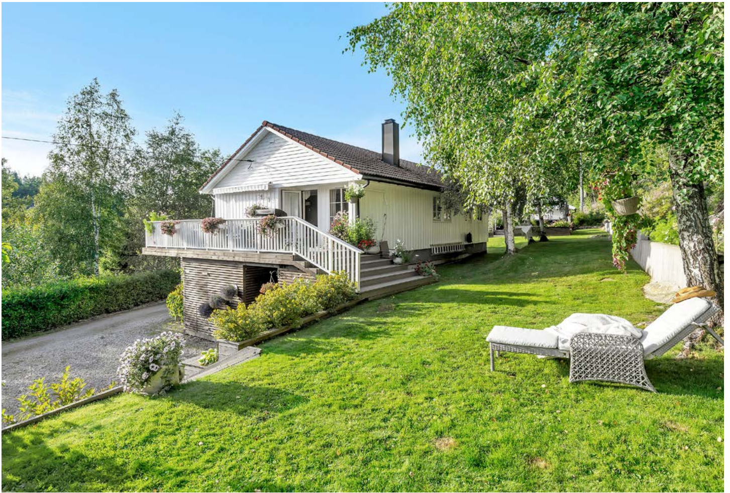
Pent opparbeidet tomt med plen, blomsterbed, hekk/busker, trær, m.m.
