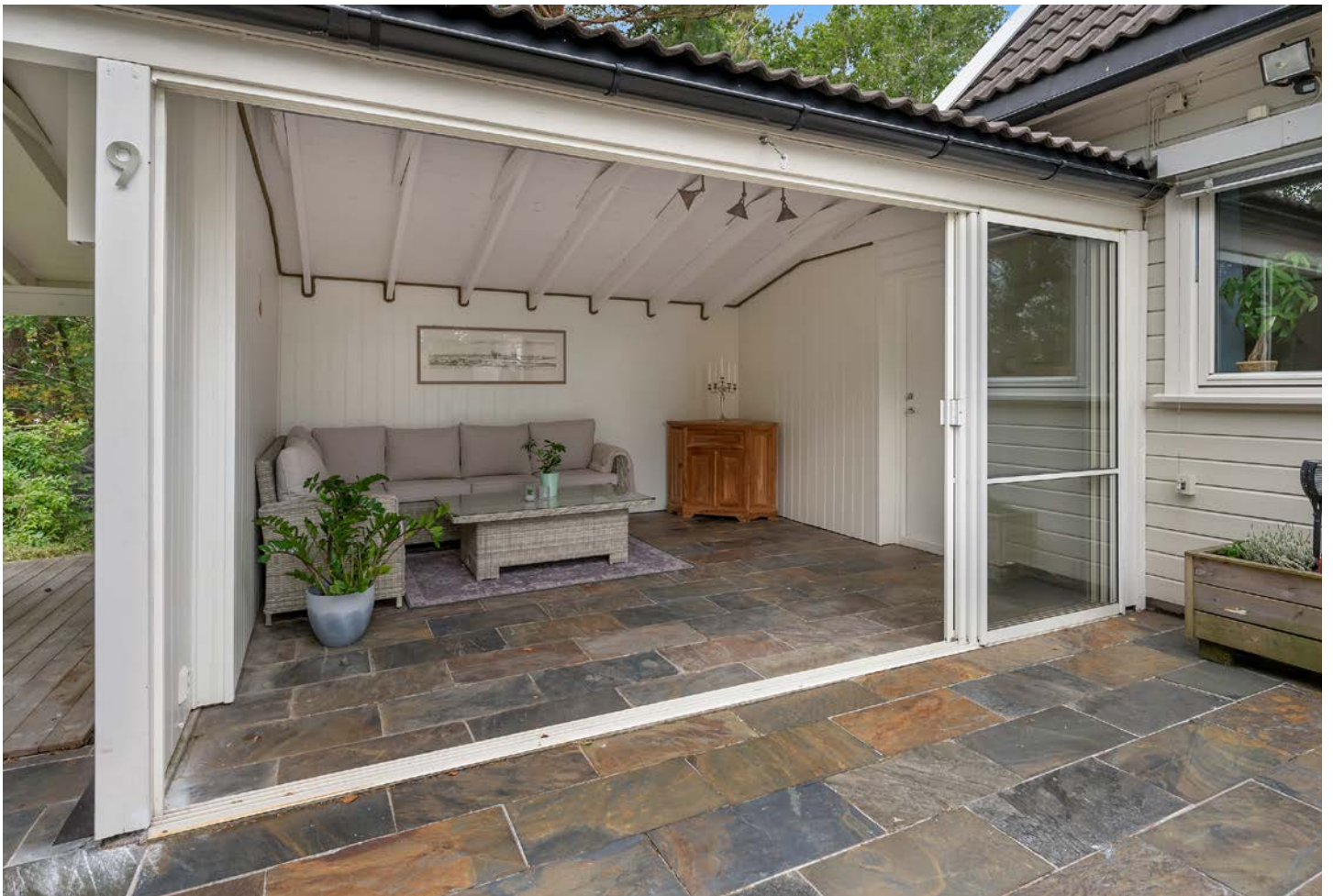
Ut fra stuen er det en stor og usjenert plattung med hagestue (ikke søkt om)
