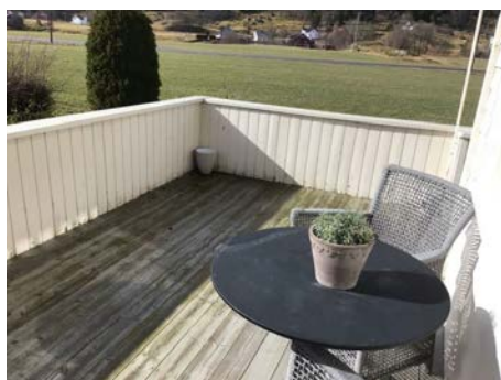
Råteskader i panel på innsiden av rekkverket
