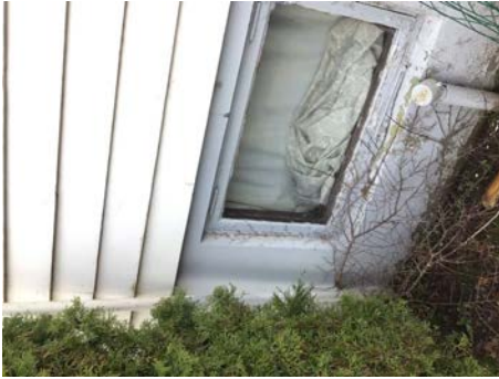
Fyllingsrør plassert under kjellervindue
