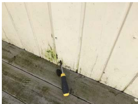
Råteskader i panel på innsiden av rekkverket
