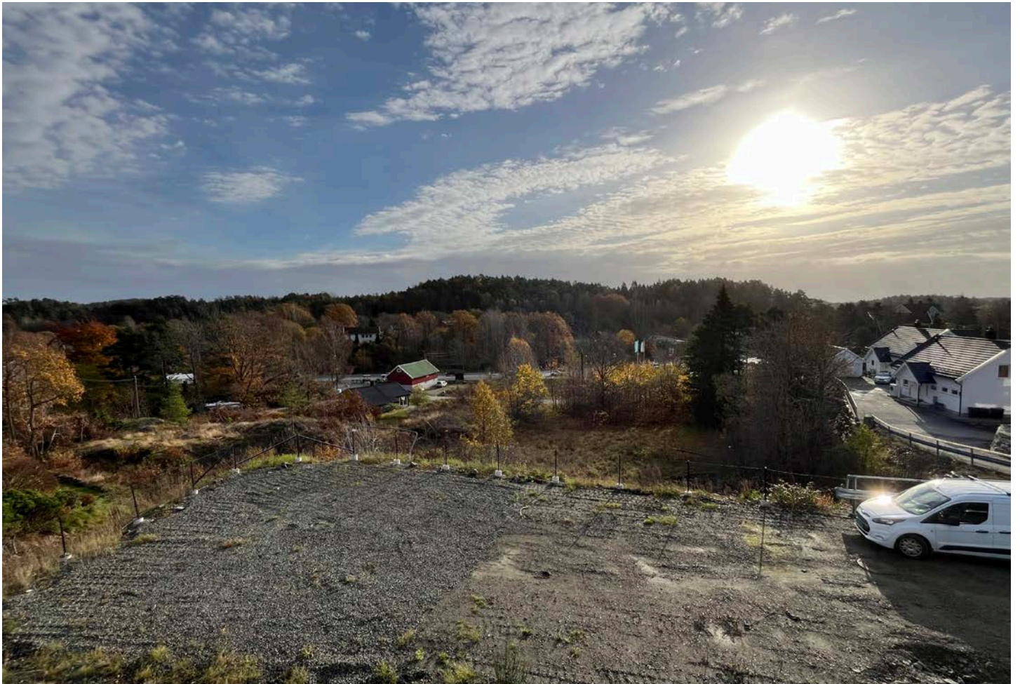
Tomtene leveres ferdig planert med vann og avløp til tomtengrense
