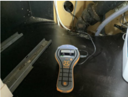
Hulltaking i vegg.
