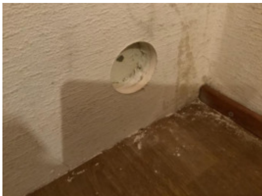
Hulltaking i yttervegg.
