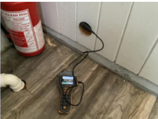
Hulltaking i vegg.
